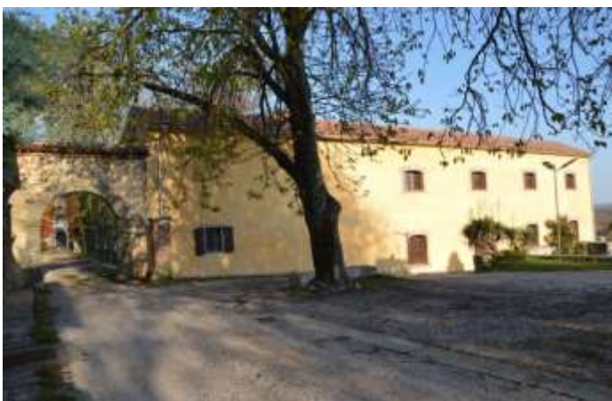
Slika 60. Sv. Martin, ulaz u ladanjski kompleks Battiala-Lazzarini i zapadno pročelje gospodarske zgrade, 19. st.
