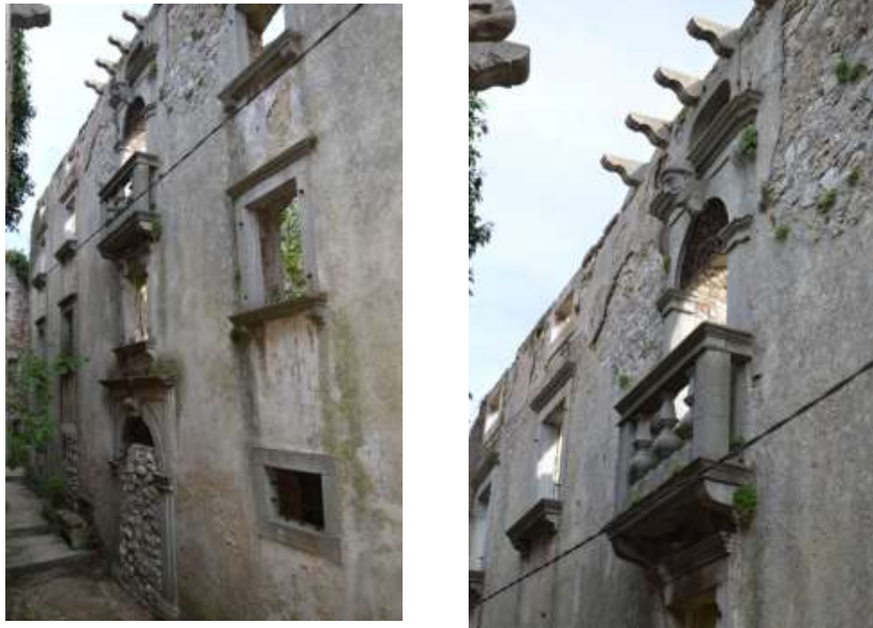
Slike 104. i 105. Plomin, palača Rudan, 18. st, sjeverno pročelje (foto: K. Rabar, 2022.)
