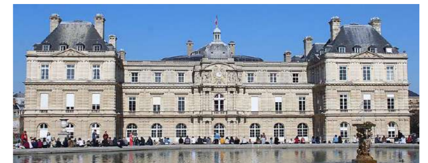
SLIKA 35. Pročelje Luksemburške palače, Pariz, 17. st.; Foto: Chabe01 (CC BY-SA 4.0)
