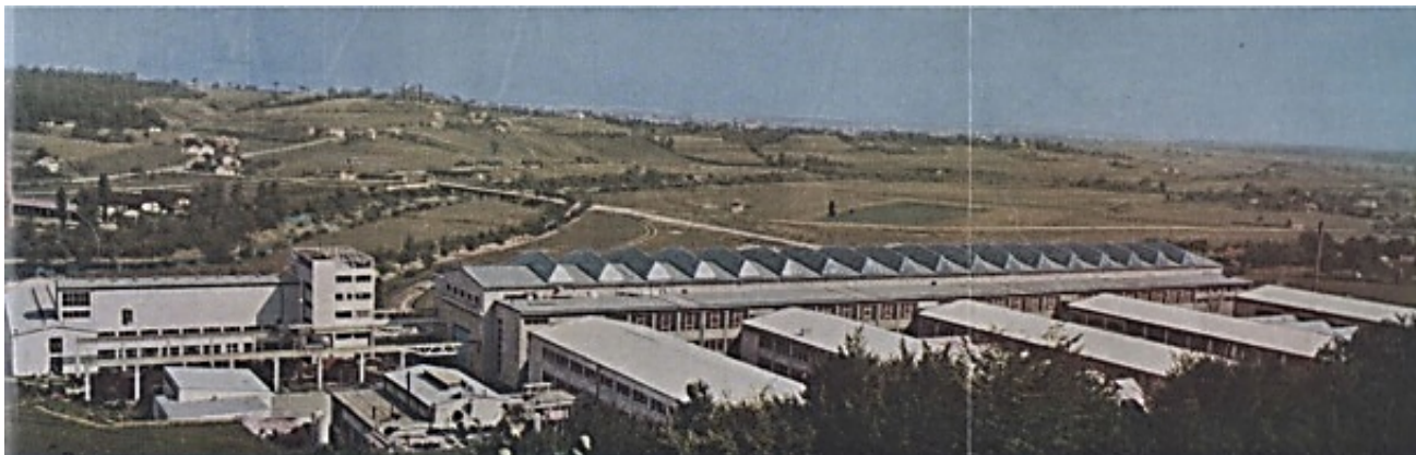
Slika 18. Jugoturbina u prošlosti
