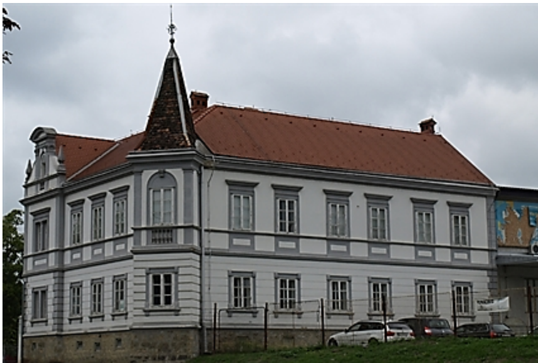
Slika 14. Upravna zgrada tvornice ŽE-ČE
