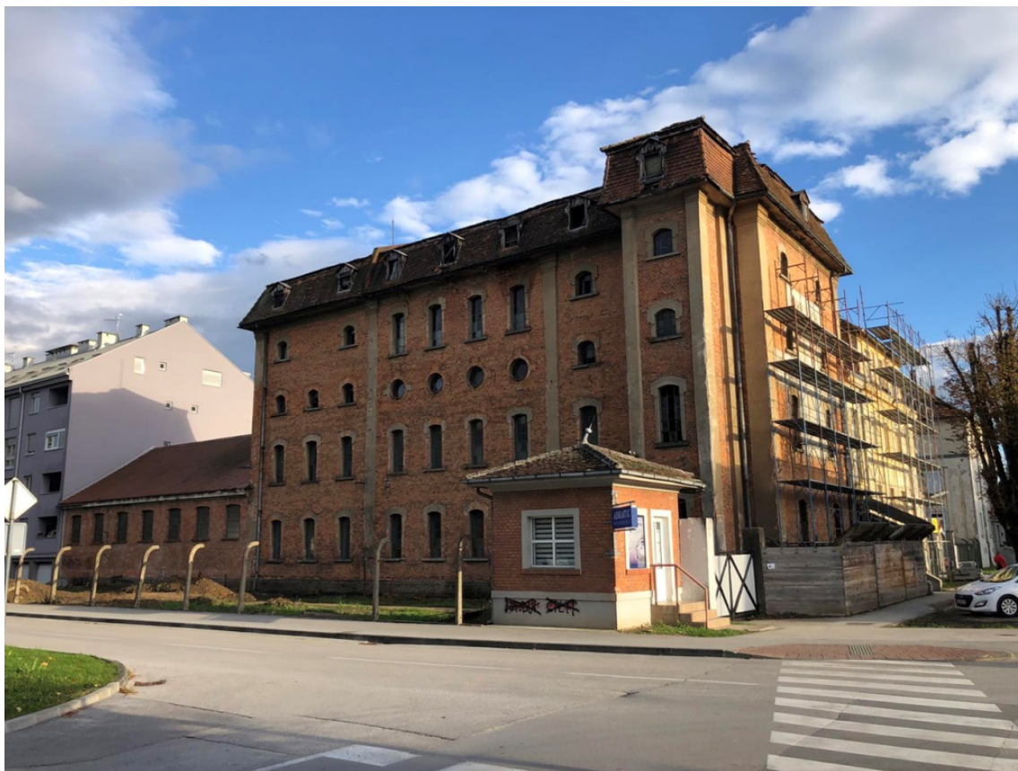
Slika 34. Stanje tijekom obnove poslovne zgrade bivšeg Mustada
