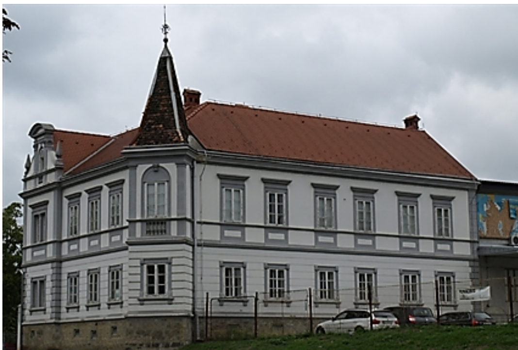
Slika 14. Upravna zgrada tvornice ŽE-ČE
