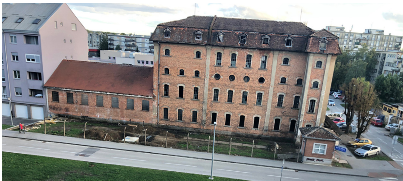
Slika 32. Stanje poslovne zgrade bivšeg Mustada prije obnove
