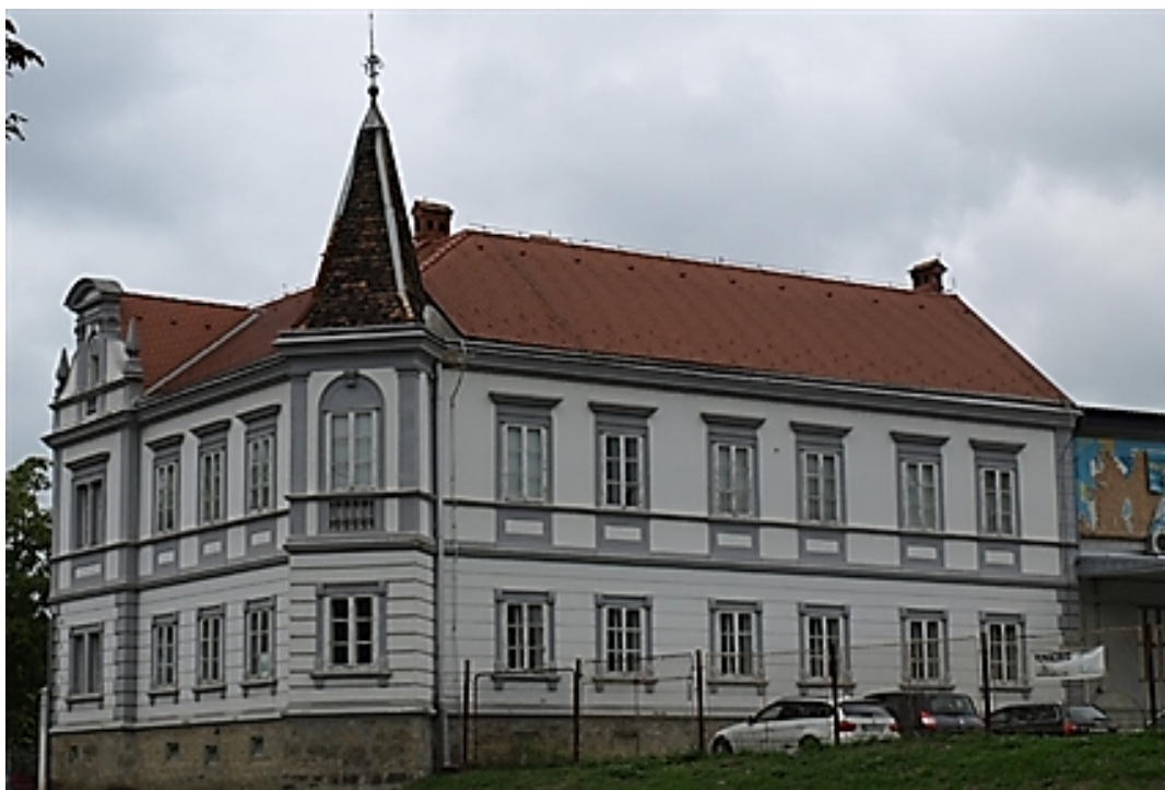
Slika 14. Upravna zgrada tvornice ŽE-ČE
