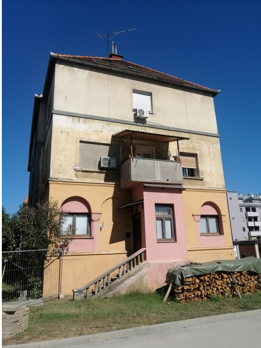
Slika 13. Događena stambena zgrada, južno pročelje, 2022.
