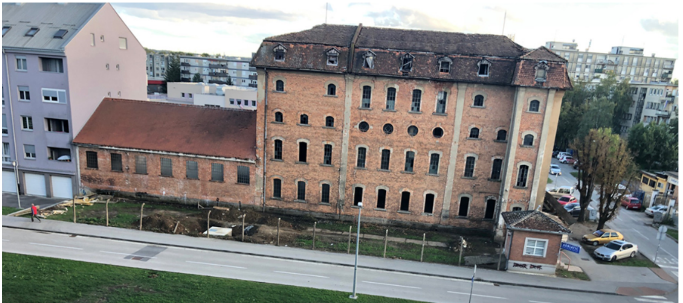
Slika 32. Stanje poslovne zgrade bivšeg Mustada prije obnove
