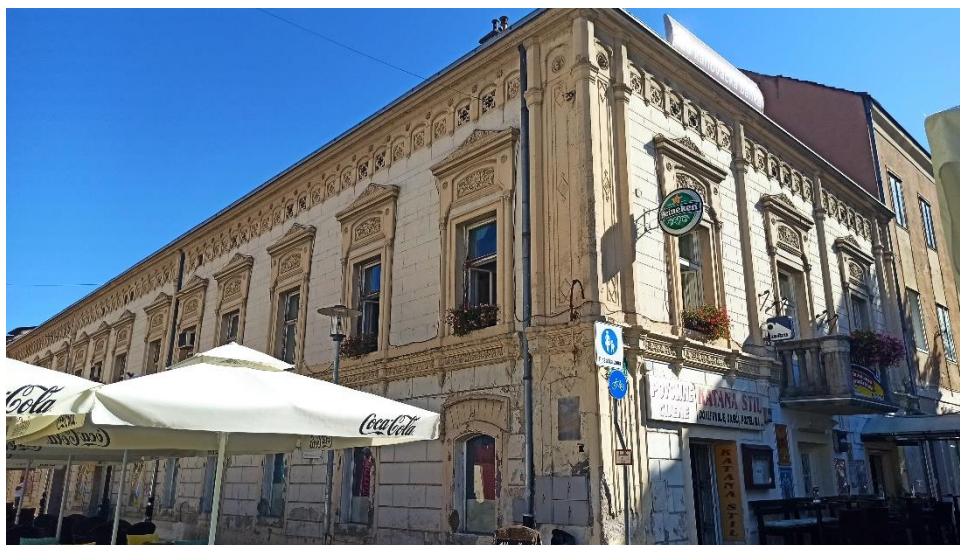
Uglovnica u Šebetićevoj ulici 2 (Nova kuća Türk), 1880ih
