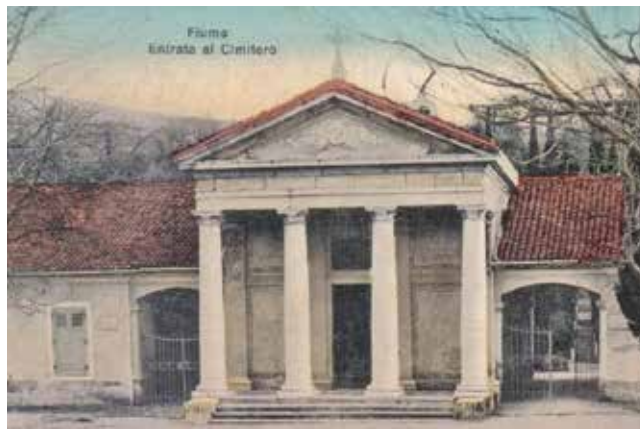
7. Porušena kapela sv. Mihovila na ulazu u Gradsko groblje Kozala, Rijeka (Daina Glavočić, Kozala , 2002., 35)
