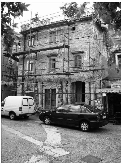
Sl. 11. Senj, pogled na Ložu nakon uklanjanja žbuke (foto: Blaženka Ljubović, 2003.)
