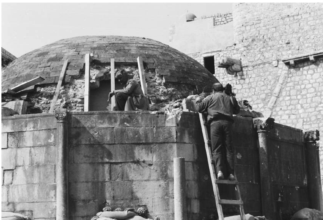
8 Zaštitni radovi na Velikoj Onofrijevoj fontani u Dubrovniku nakon granatiranja, dokumentacija (Ratne štete) Uprave za zaštitu kulturne baštine Ministarstva kulture i medija
