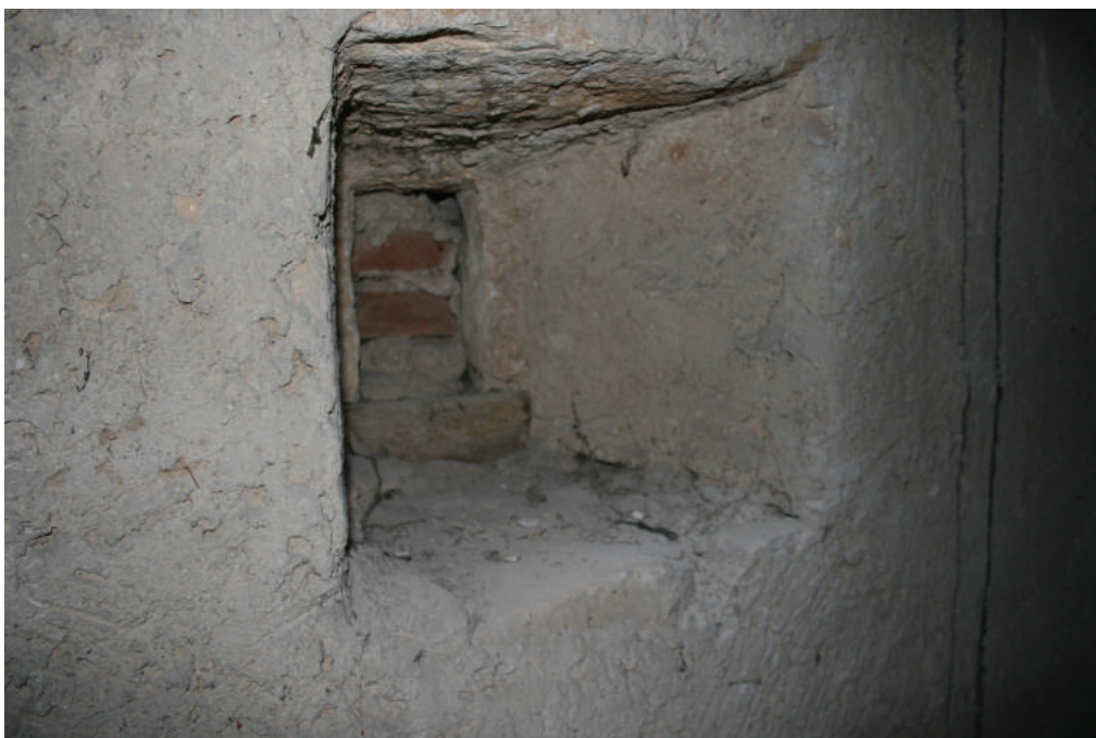
6 Knežinec, crkva sv. M. Magdalene, zazidani otvor vidljiv u tavanском prostoru crkve, foto: I. Peškan
