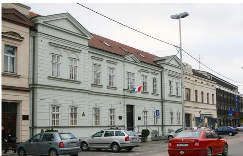
Slika 10. Zgrada kotarskog suda (danas općinski sud)
