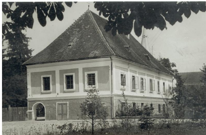
Slika 21. Stara razglednica gradske vijećnice prije obnove prizemlja (prije 1977.) na kojoj se vidi drugačiji kontrast boja vijenaca i lezena na pročelju nego danas
