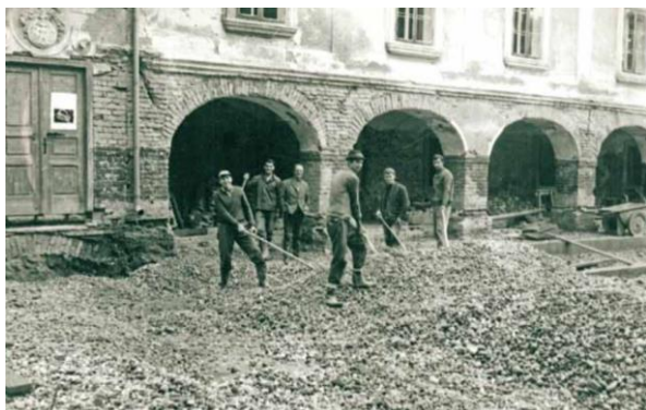
Slika 31. Drenaža i zaštita zgrade Muzeja Turopolja od vlage, 1969.
