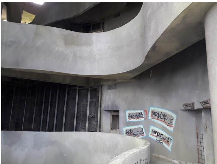
Slika 54. Ograde stubišta/rampe.. Fotografija iz vlastite arhive (2023).
