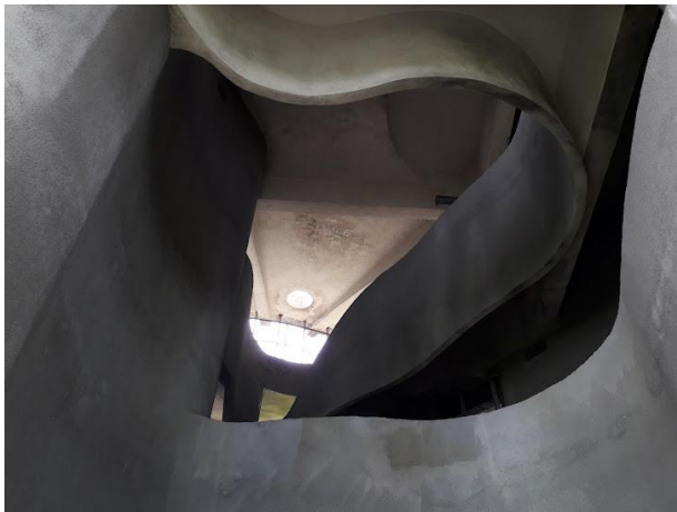
Slika 53. Dijelovi stubišta. Fotografija iz vlastite arhive (2023.).
