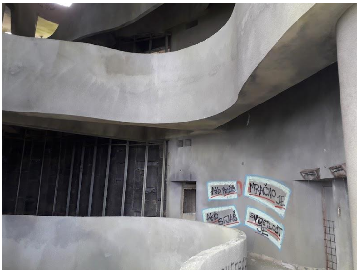
Slika 54. Ograde stubišta/rampe.. Fotografija iz vlastite arhive (2023).
