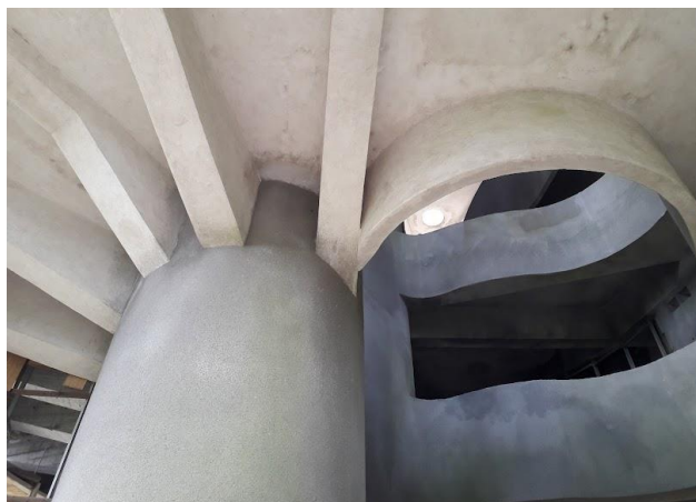
Slika 55. Pilon koji nosi dio stubišta na gornjim katovima. Fotografija iz vlastite arhive (2023.).
