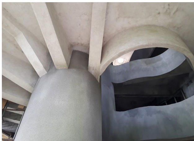
Slika 55. Pilon koji nosi dio stubišta na gornjim katovima. Fotografija iz vlastite arhive (2023.).
