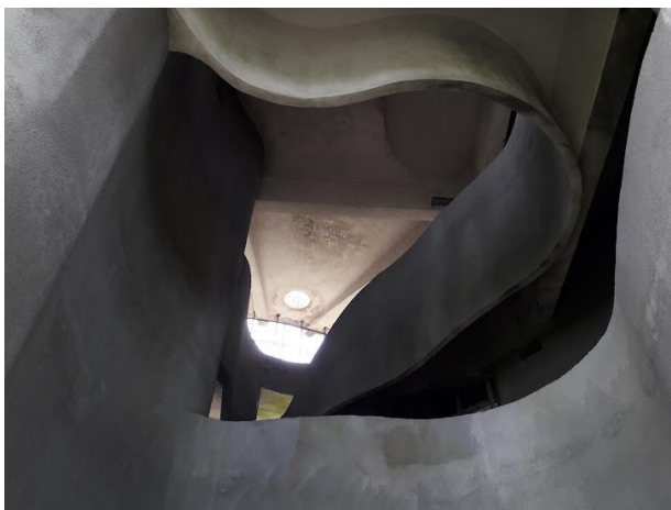
Slika 53. Dijelovi stubišta. Fotografija iz vlastite arhive (2023.).
