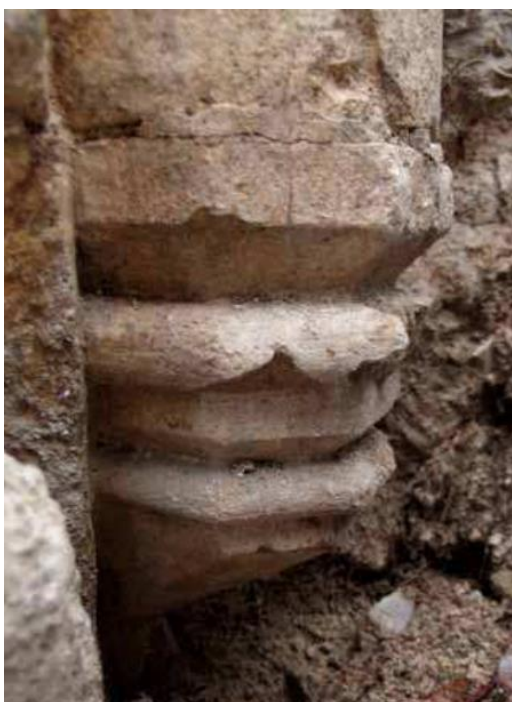
Slika 6. Konzola na spoju južnog i istočnog zida unutar kapele (fotografirala: Marijana Korunek)
