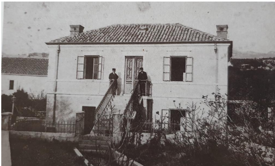
Slika 1. Obiteljska kuća u Kraljevici
