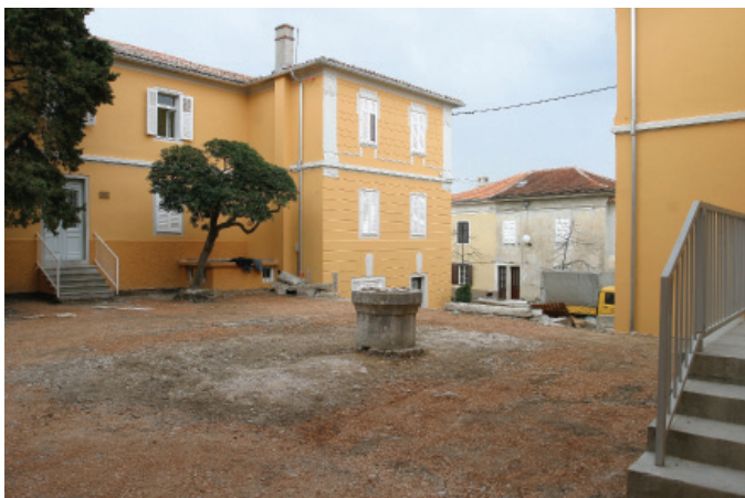
Položaj do danas sačuvane cisterne nekadanje utvrde s novim grlom i zgrada župnog stana podignuta na mjestu nekadanje kule Ivana VII. Mlađeg Frankapana (snimio Damir Krizmanić)
