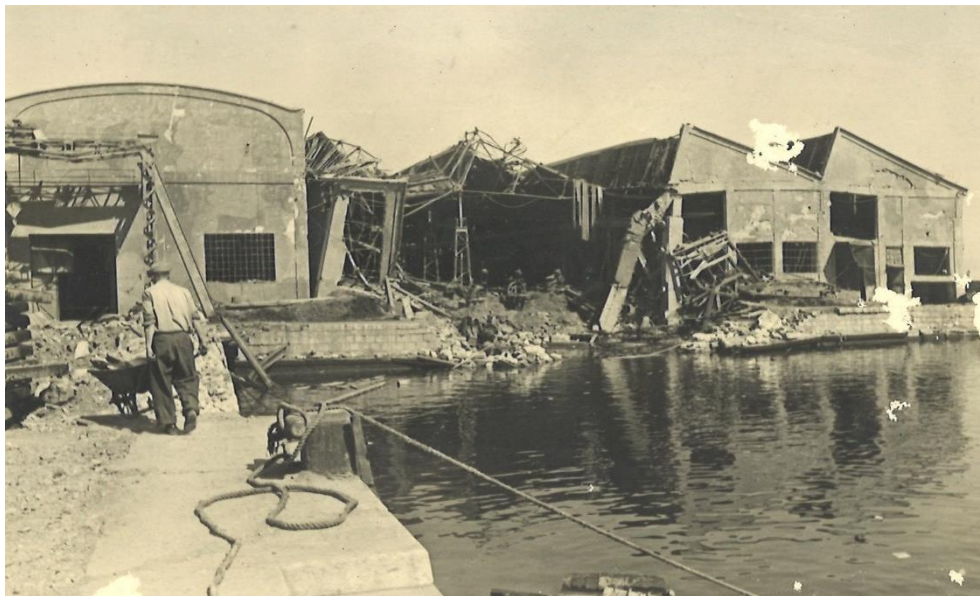
Slika 6. Uništena postrojenja tvornice Torpedo
