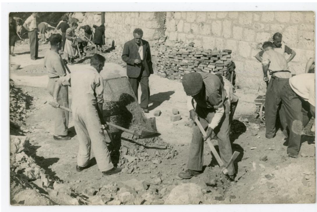
Slika 5. Rad na obnovi grada
