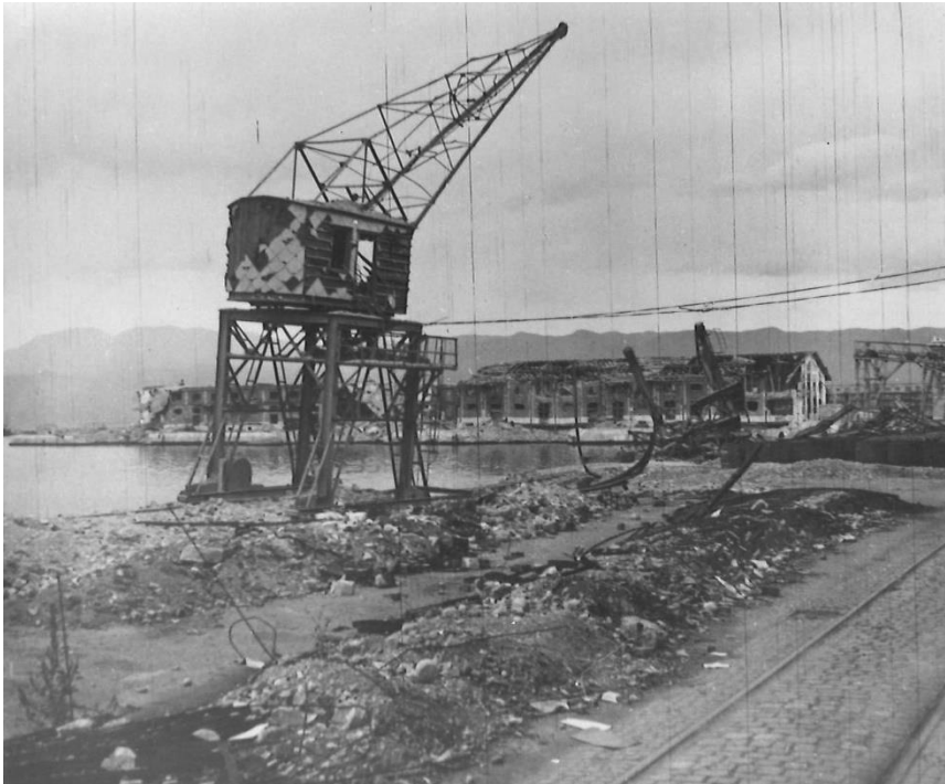
Slika 1. Oštećena lučka infrastruktura
