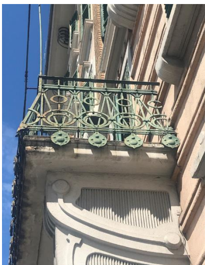
Slika 57. Detalj pročelja s balkonom (Venceslao Celligoi, Kuća Woloschin , 1908., Osječka 4), foto Luka Štimac.
