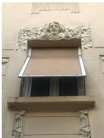
Slika 90. Detalj sjevernog pročelja u razini drugog kata (nepoznati autor, kuća/vila Hodak , 1912. Šetalište Ivana Gorana Kovačića 14), foto Luka Štimac
