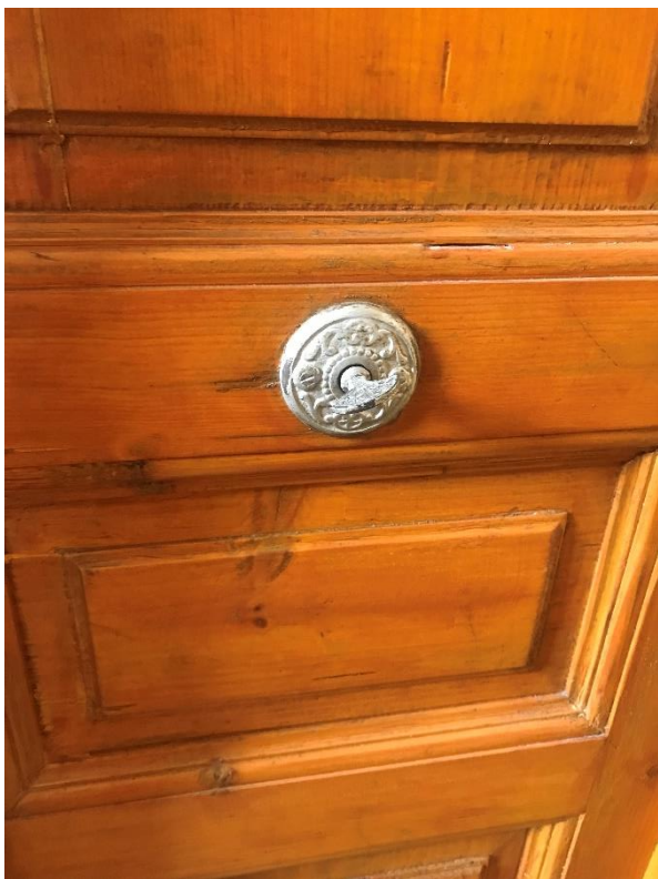
Slika 104. Detalj vrata s mehaničkim zvoncem (Giuseppe Farkas, Kuća Wotzelka-Schwarz , 1913., Osječka 6), foto Luka Štimac.
