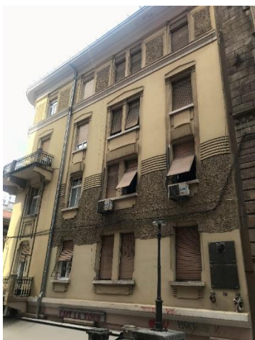
Slika 79. Bočno ili istočno pročelje kuće (Emilio Ambrosini, Kuća Tomašić , 1912., Fiorella La Guardije 8, 8A, 8B/Ulica Blaža Polića 7), foto: Luka Štimac.
