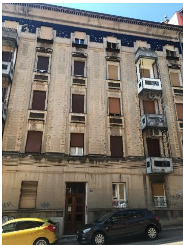
Slika 35. Ulično pročelje (Giuseppe Farkas, Kuća Hering-Székely, 1909., Laginjina ulica 17), foto Luka Štimac.
