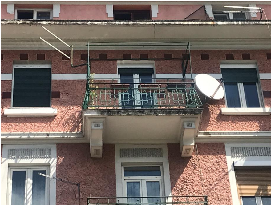
Slika 113. Detalj gornjeg dijela pročelja (Giuseppe Farkas, Kuća Wotzelka-Schwarz , 1913., Osječka 6), foto Luka Štimac.
