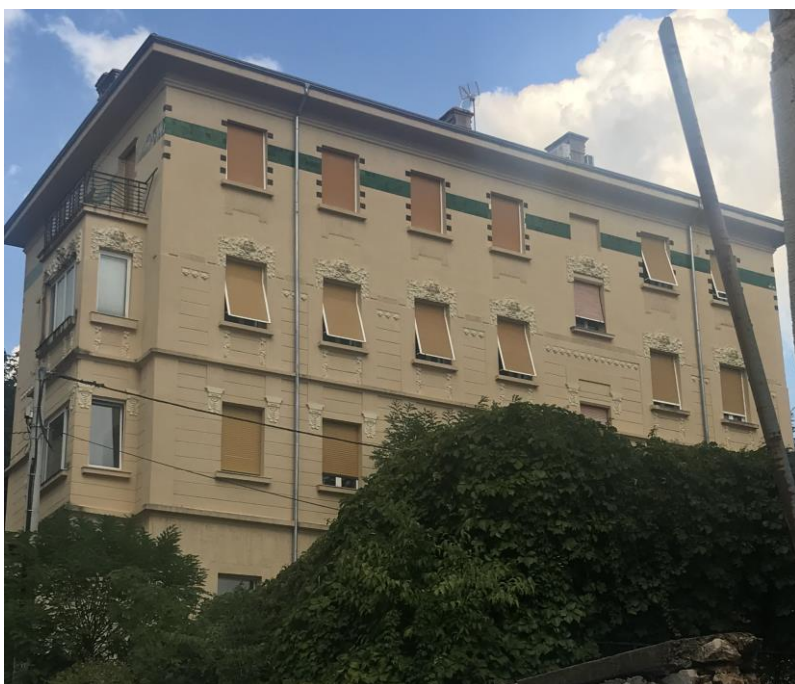
Slika 98. Južno pročelje (nepoznati autor, kuća/vila Hodak , 1912. Šetalište Ivana Gorana Kovačića 14), foto Luka Štimac
