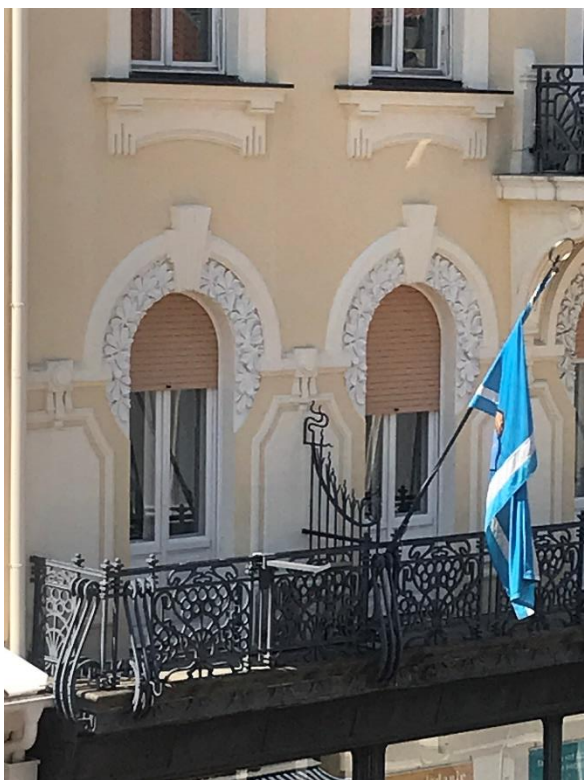
Slika 91. Detalj pročelja s dekoracijom kestenova lišća (Emilio Ambrosini, Hotel Royal , 1906., Korzo 9/Adamićeveva 10), foto Luka Štimac.
