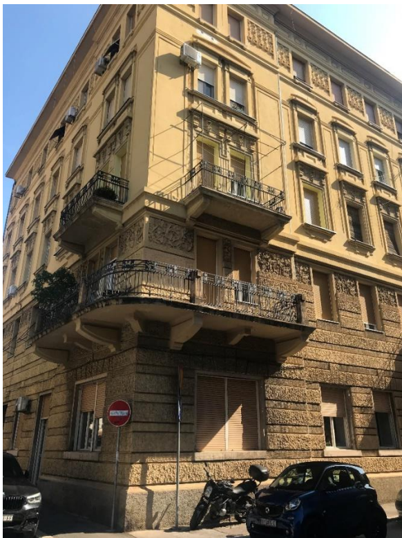
Slika 80. Ulična pročelja kuće (Emilio Ambrosini, Uglovnica za Unione Cooperativa Fiumana , 1908., Rikarda Katalinića Jeretova 8A), foto Luka Štimac.
