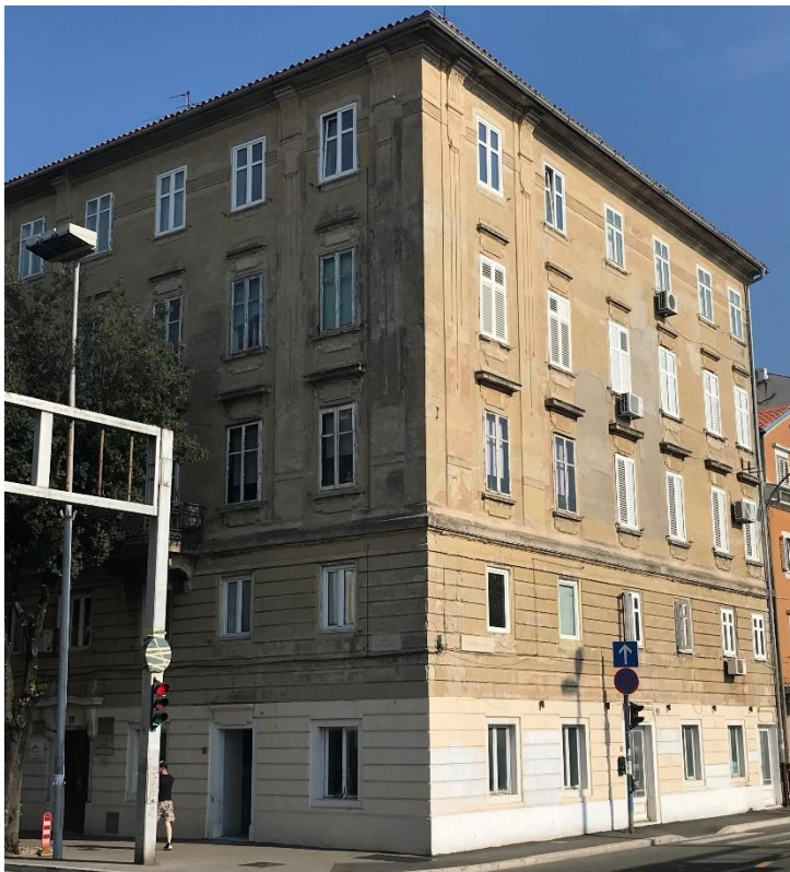
Slika 20. Ulična pročelja (Giovanni Rubinich, Kuća Steinmann , 1905., Ulica Ivana Zajca 2/Ribarska ulica 5), foto Luka Štimac.
