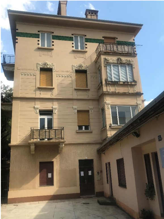
Slika 96. Zapadno pročelje (nepoznati autor, kuća/vila Hodak , 1912. Šetalište Ivana Gorana Kovačića 14), foto Luka Štimac
