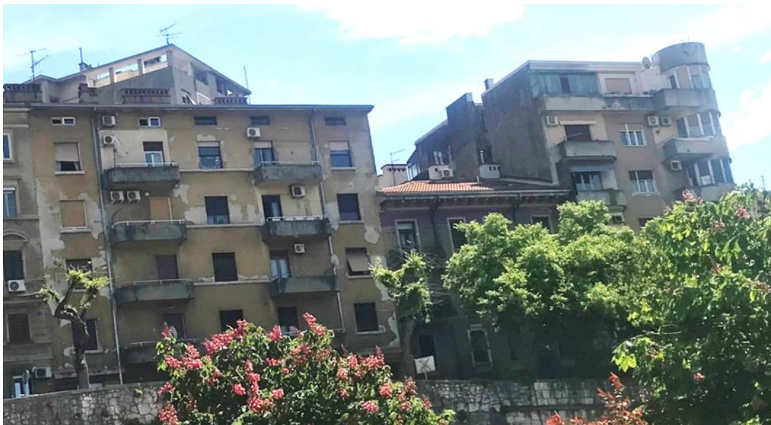
Slika 64. Pogled na stambeni niz u Ulici 1. maja, foto Luka Štimac
