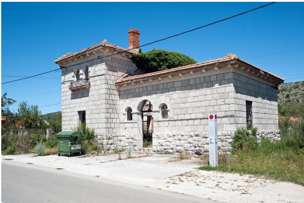
Zgrada Antimalarične stanice
