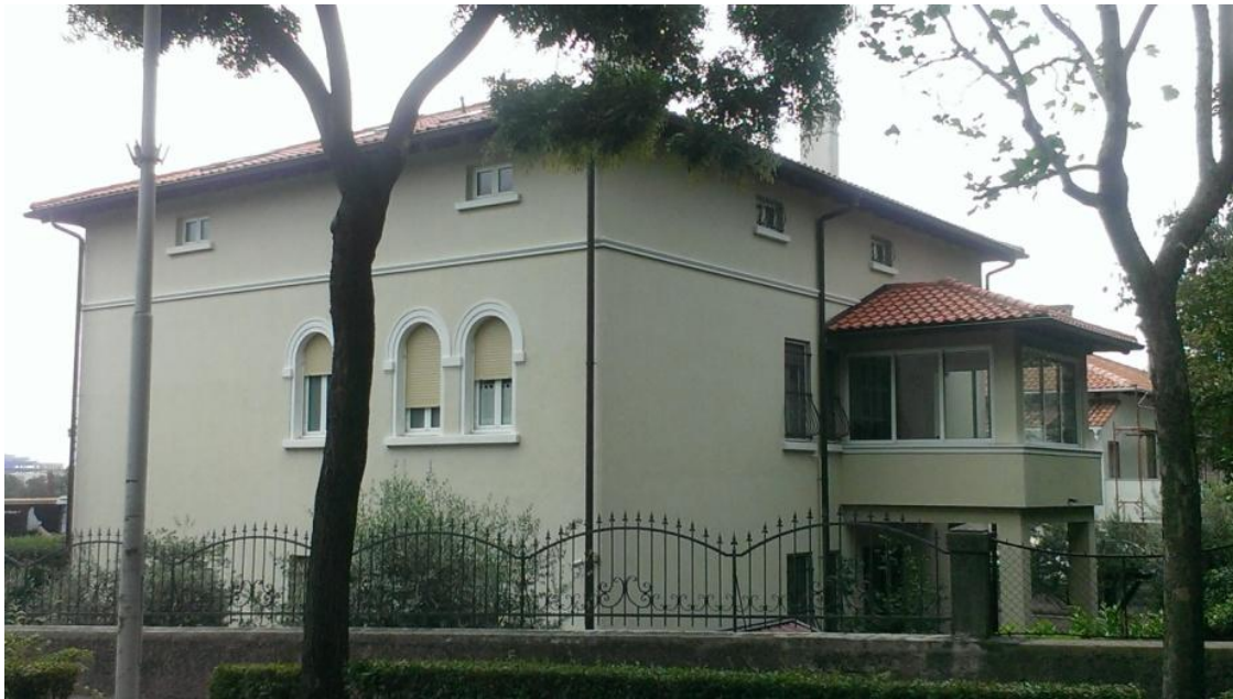
Obiteljska kuća Đorđević, Kumičićeva ulica 81, Trsat, Rijeka – bok i začelje (f. S.M.)
