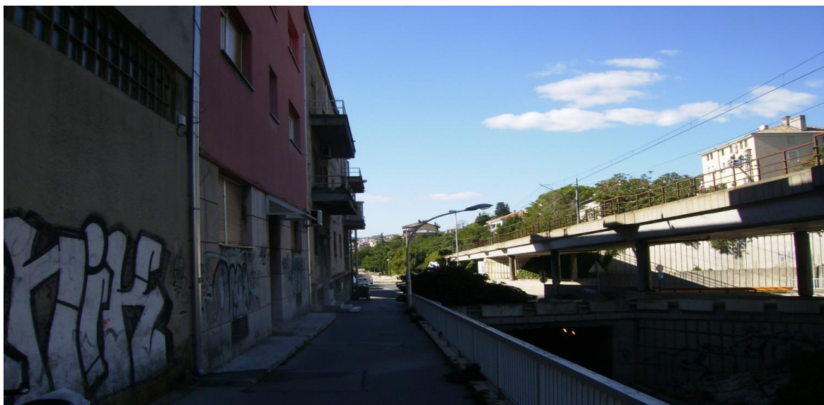
Slika 7. Kuća Alga, začelje – zapadni dio (f. S.M.)
