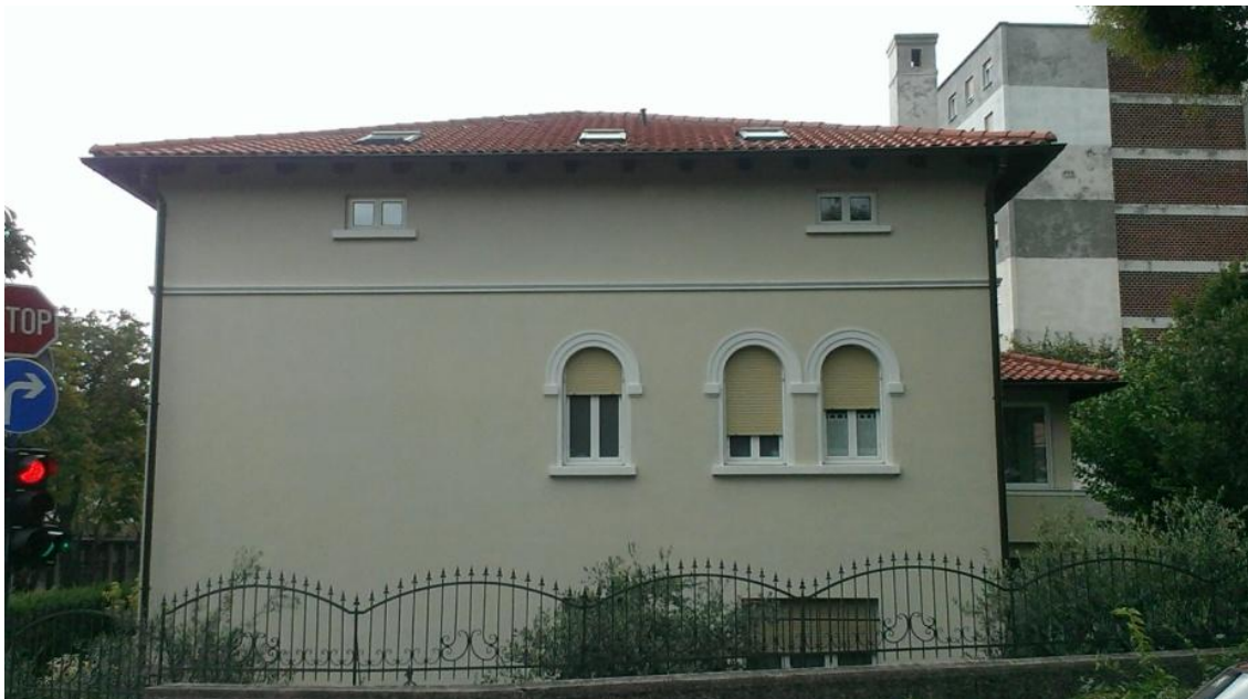
Obiteljska kuća Đorđević, Kumičićeva ulica 81, Trsat, Rijeka – začelje (f. S.M.)
