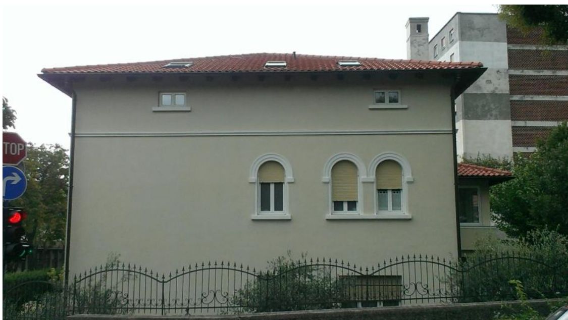
Obiteljska kuća Đorđević, Kumičićeva ulica 81, Trsat, Rijeka – začelje (f. S.M.)
