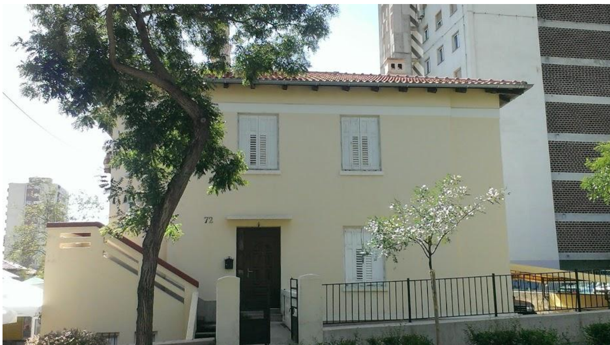
Obiteljska kuća u Ulici Slavka Krautzeka 72, Trsat, Rijeka – sjeverni bok kuće sa ulazom (f. S.M.)
