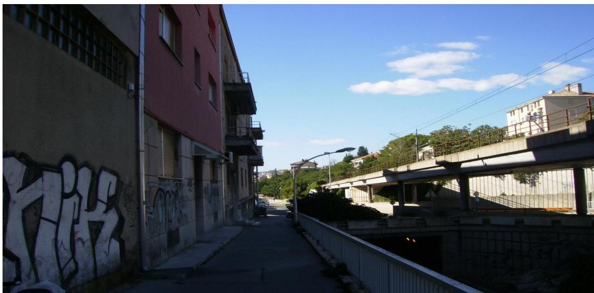
Slika 7. Kuća Alga, začelje – zapadni dio (f. S.M.)
