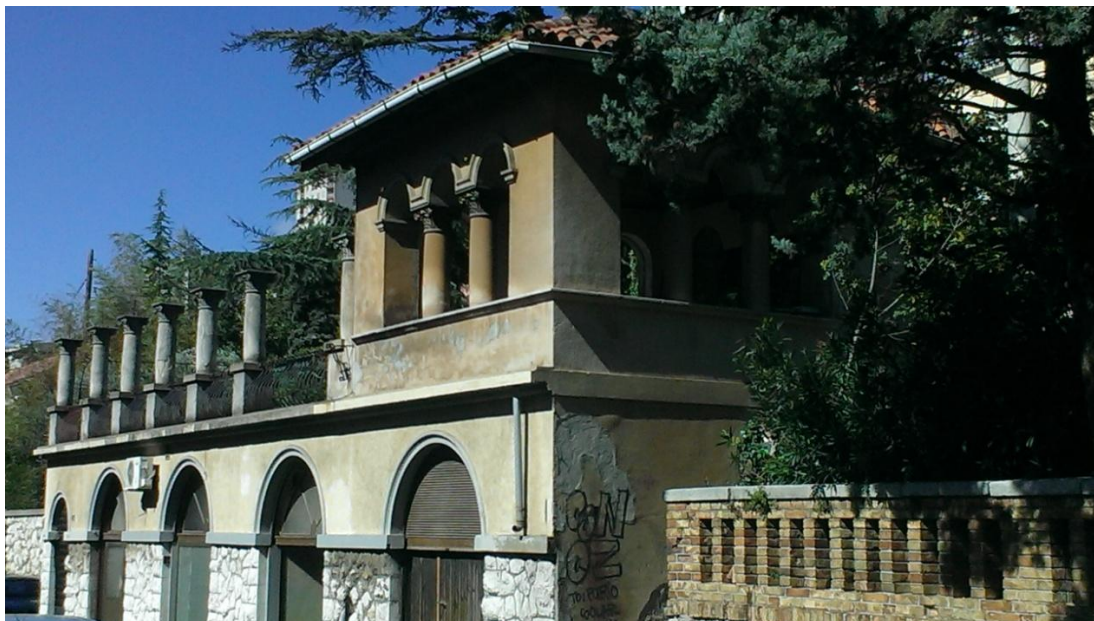
Vila Kezele - Pročeljni dio uz cestu sa poslovnim prostorima i terasom, detalj (f.S.M.)
