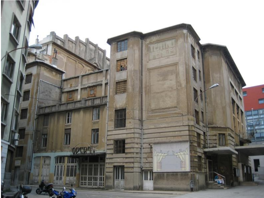
Prilog 4.4.1, Današnji izgled zgrade Teatra Fenice, izvor: http://virtualna.nsk.hr/1914/26-travnja-1914/
