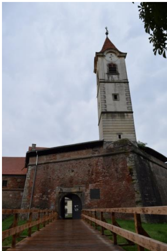
Slika 15. Ulazni bastion utvrde Čakovec, Snimila: Simona Košnjak
