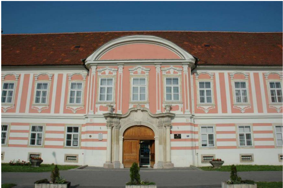
Slika 34. Glavni portal palače Erdödy-Patačić
