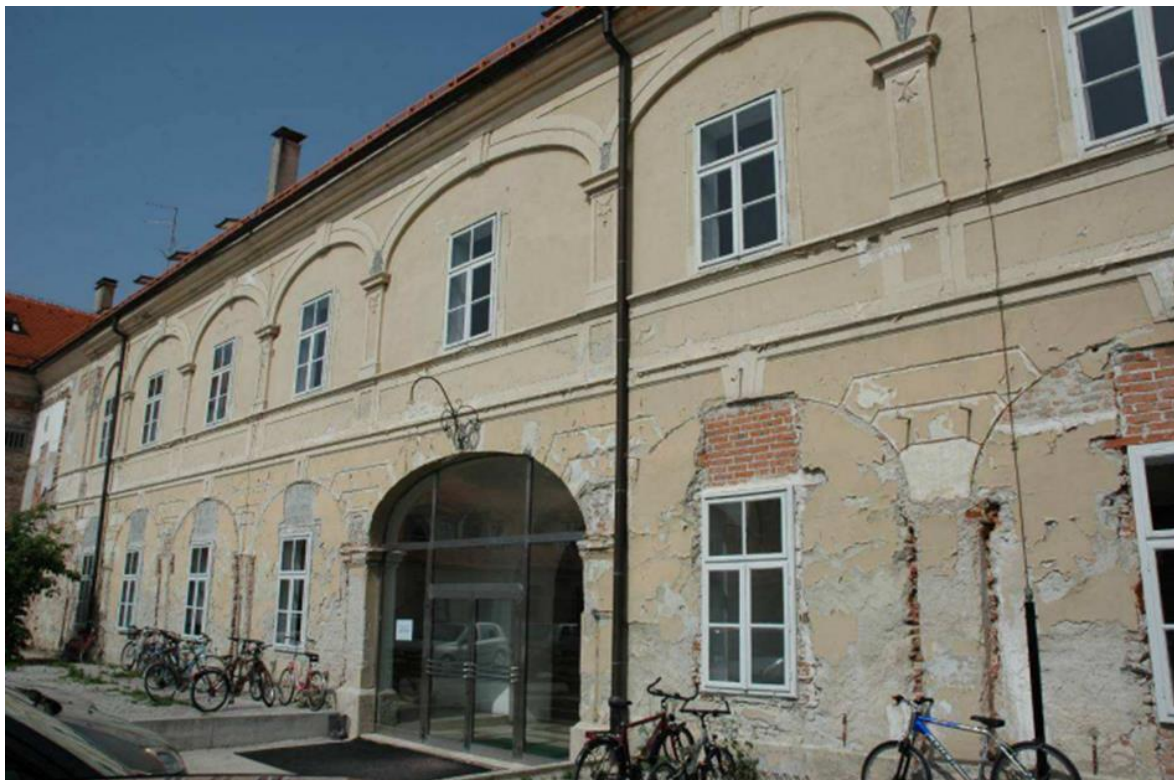
Slika 35. Začelje palače Erdödy-Patačić sa zazidanim arkadama
