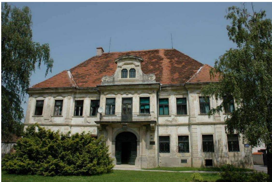
Slika 24. Glavno pročelje palače Keglević
