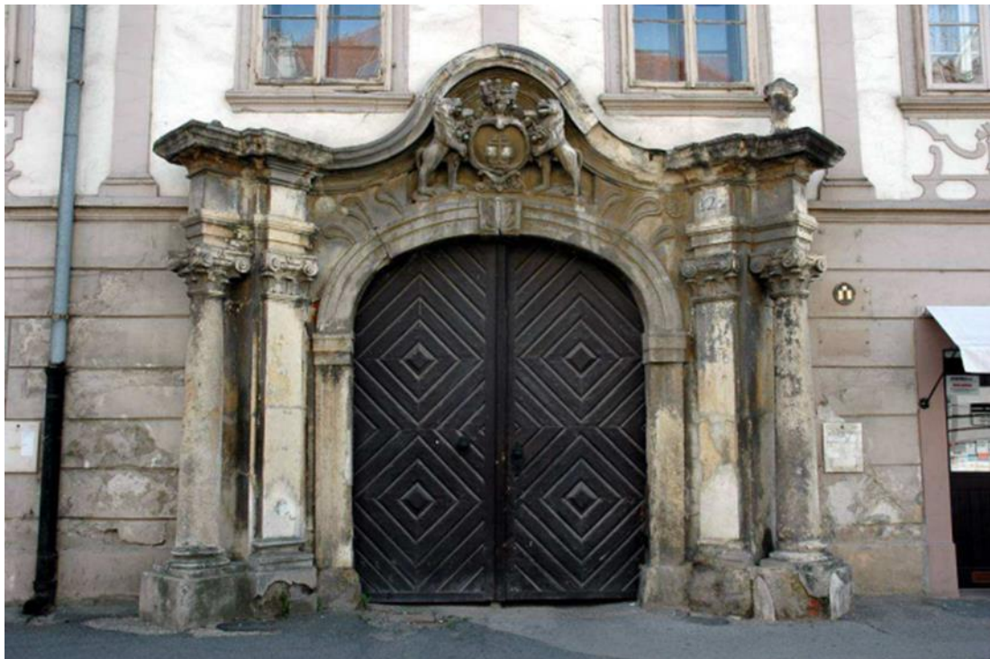
Slika 37. Glavni portal palače Patačić-Puttar
