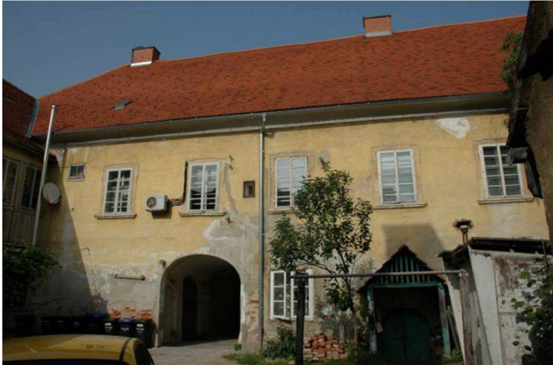
Slika 10. Začelje palače Zagrebačkog kaptola
