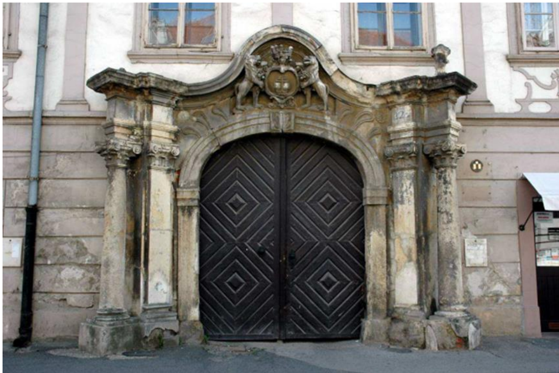
Slika 37. Glavni portal palače Patačić-Puttar
