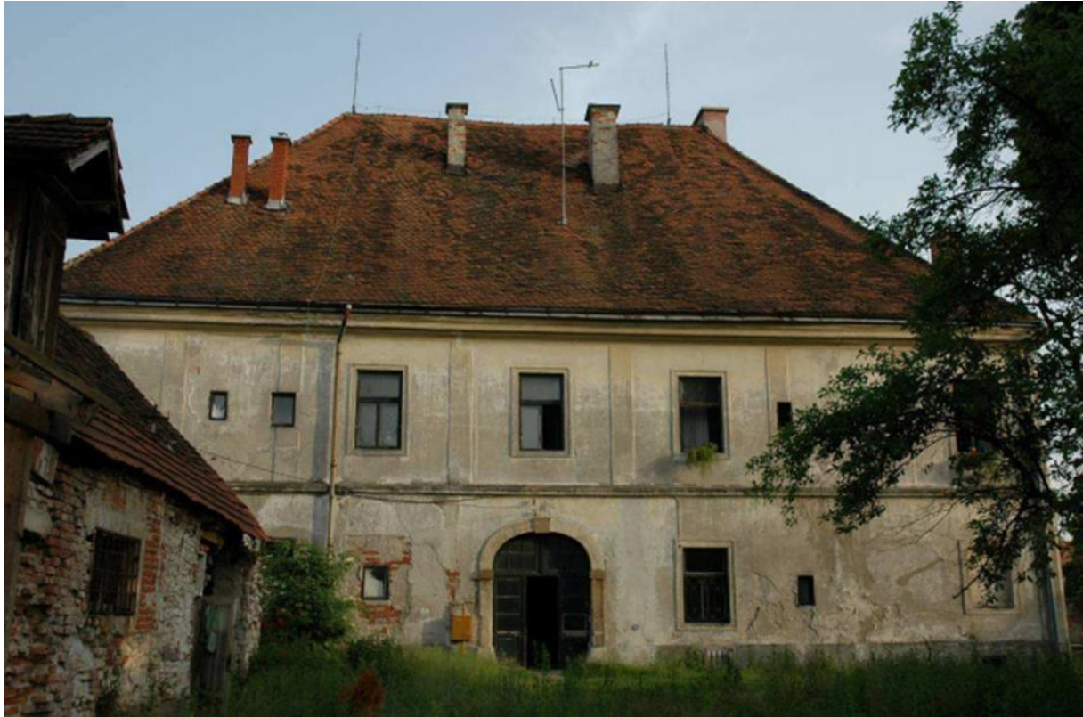
Slika 26. Začelje palače Keglević
