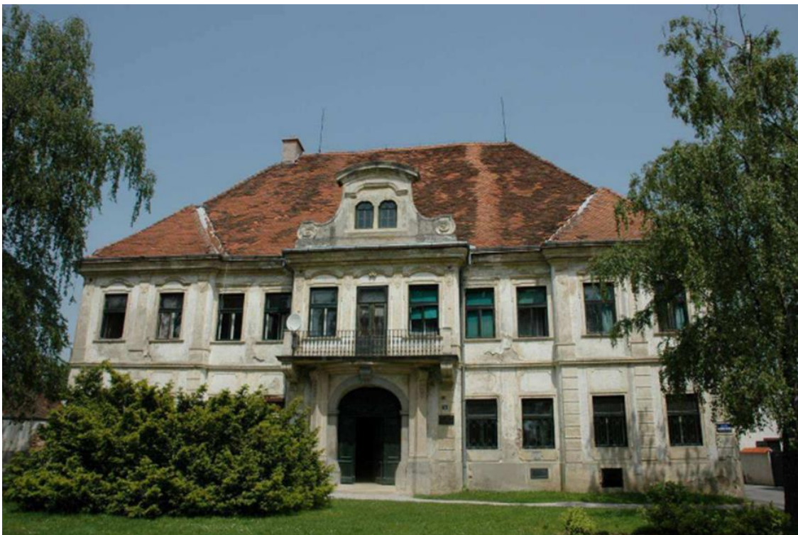
Slika 24. Glavno pročelje palače Keglević
