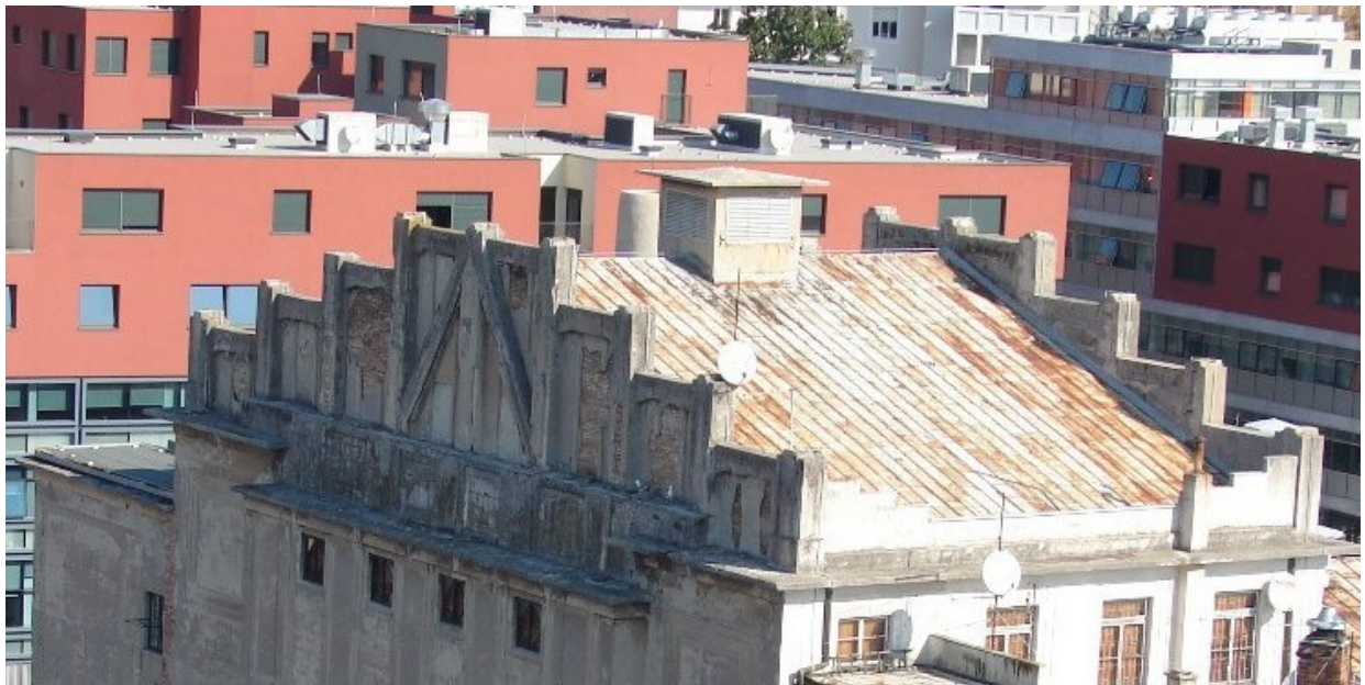
Slika 66. Detalj krovišta Teatra Fenice
