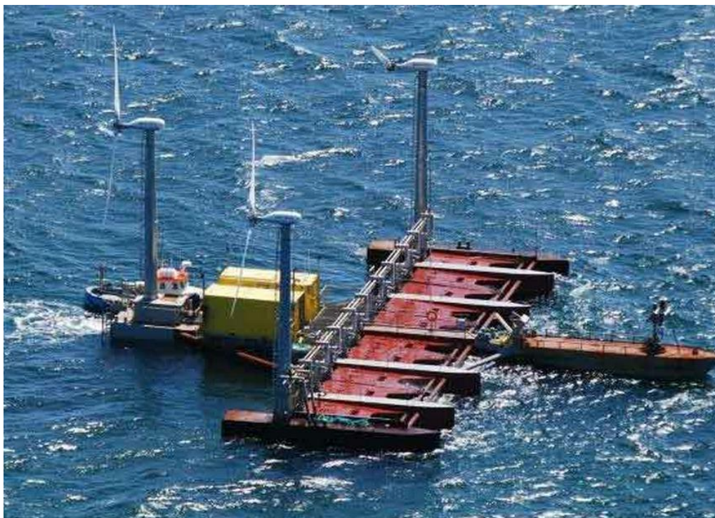
Slika 2.8. Vjetroelektrana „Posejdon“ u Danskoj.
