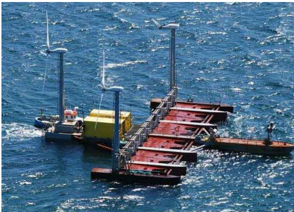
Slika 2.8. Vjetroelektrana „Posejdon“ u Danskoj.
