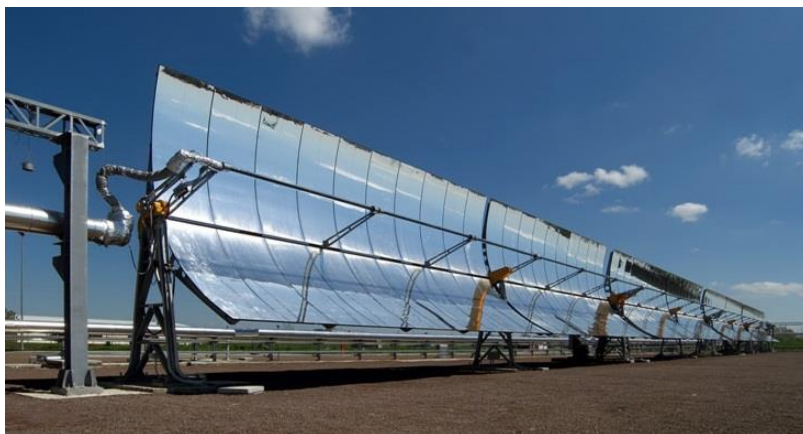
Slika 3.6. Parabolični kolektori
