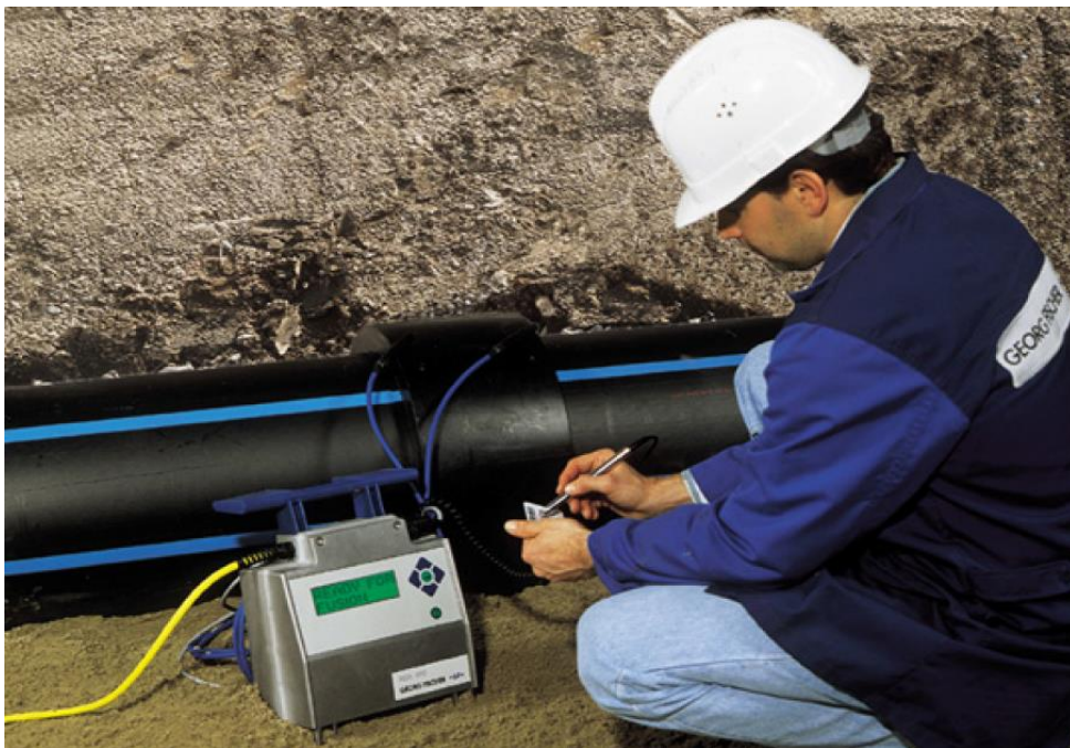
Slika 4.1. Elektrofuzijsko zavarivanje[8]
