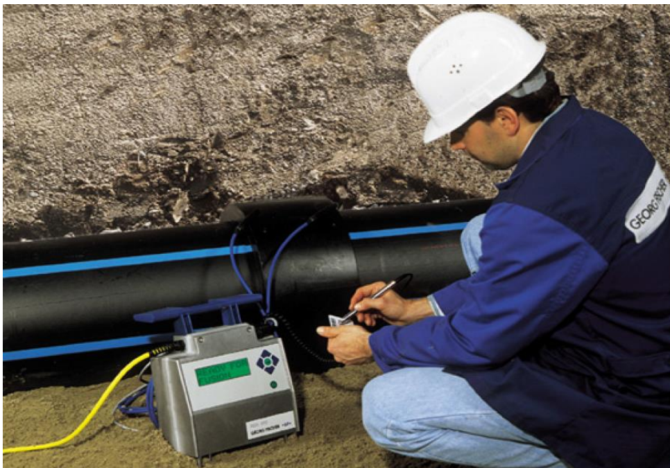
Slika 4.1. Elektrofuzijsko zavarivanje[8]
