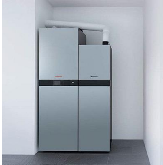
Slika 9. Viessmann uređaj na gorivne članke
