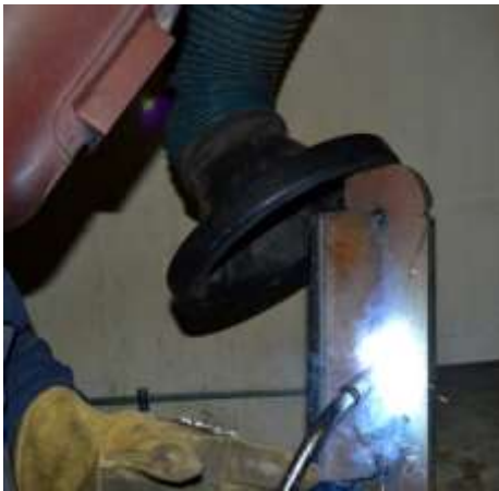
Slika 2.1. Zavarivanje MAG postupkom [8]
