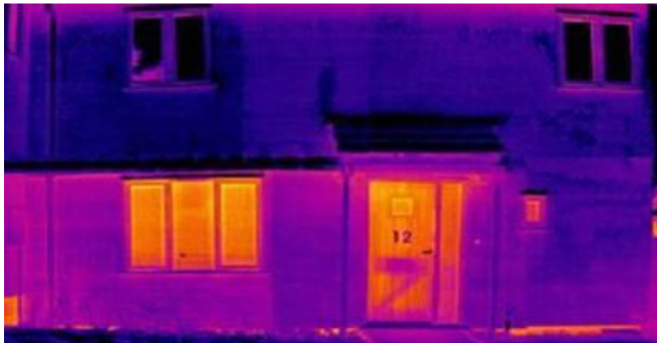
Slika 4.8. Toplinska postojanost konopljine kuće [13]
