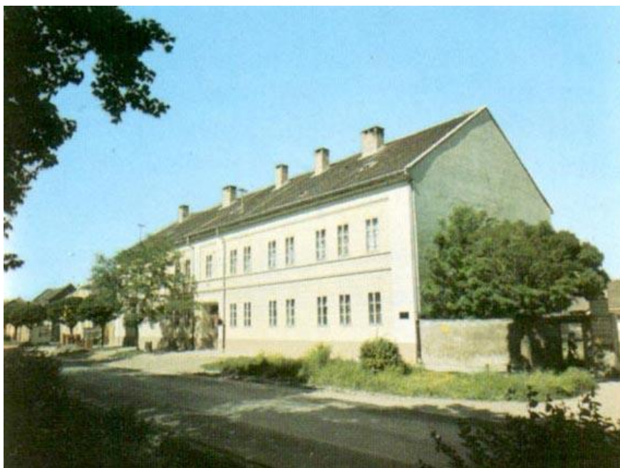
Slika 2. Ulica Petra Preradovića 17, zgrada Muzeja Đakovštine od 1967. do 1994. godine
