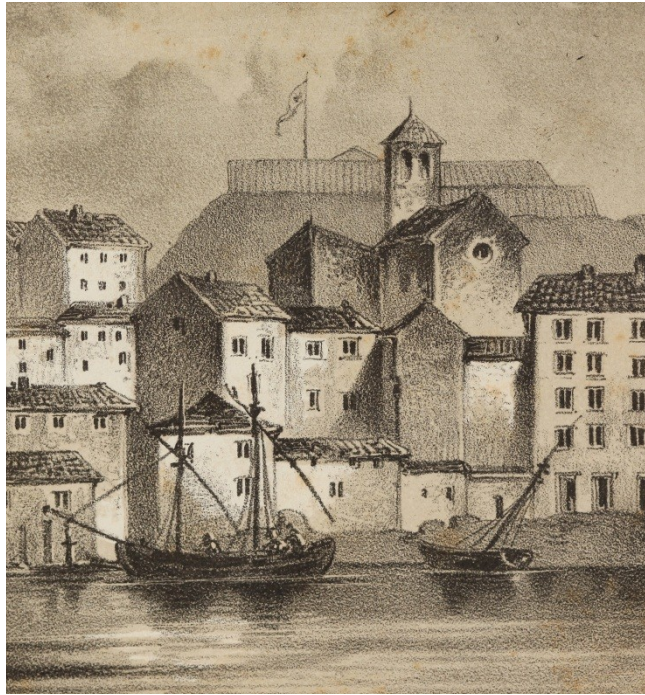
Slika 28: veduta na franjevački samostan (nepoznati autor)
