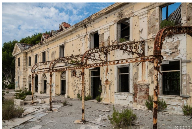
Slika 44. Hotel Grand 2016. g. (pogled s mora- južna strana)
