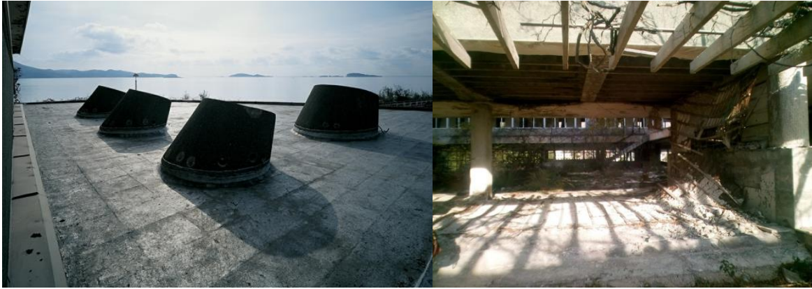
Slike 47. i 48. (lijevo) Svjetlarnici i (desno) armirano-betonska pergola iznad ulaza u hotel Pelegrin
