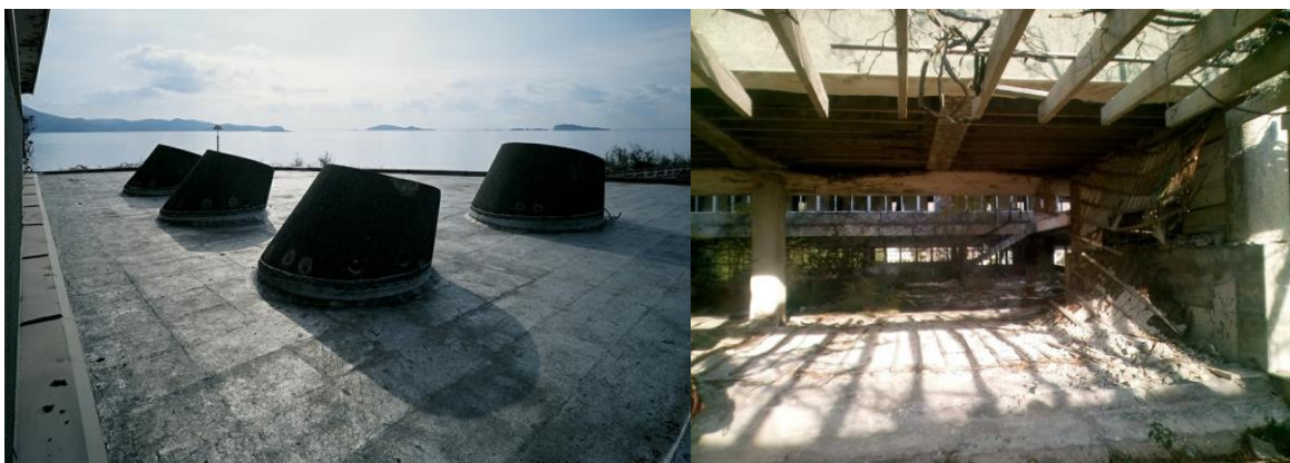
Slike 47. i 48. (lijevo) Svjetlarnici i (desno) armirano-betonska pergola iznad ulaza u hotel Pelegrin
