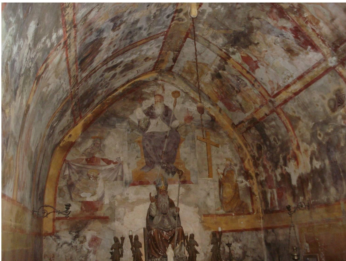
Slika 41. Dominik iz Udina i suradnici, pogled na istočni zid, Sv. Antun Pustinjak, Višnjan
