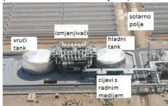
Sl. 4.2. Hladni i vrući tank rastaljene soli integriran u solarnu termoelektranu s paraboličnim žljebastim kolektorima [32]
