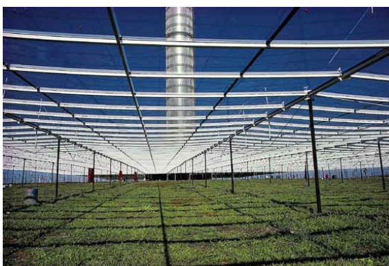
Sl.3.22. Plantaža ispod kolektora elektrane koji služe kao staklenici [30]
