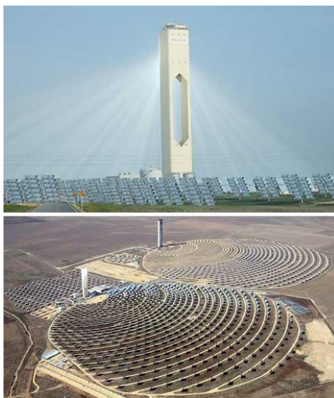
Sl. 3.13. Slika s tla i panoramska slika Solarne termoelektrane PS-10 i PS-20 kod Seville [21]
