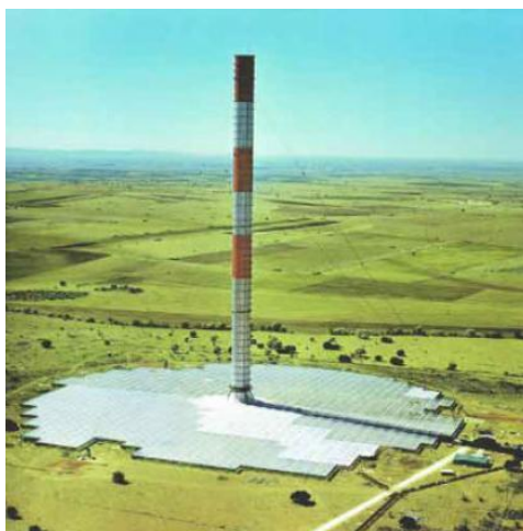
Sl. 3.21. Solarna dimnjačna termoelektrana u Manzanaresu [29]
