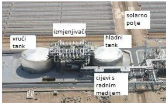
Sl. 4.2. Hladni i vrući tank rastaljene soli integriran u solarnu termoelektranu s paraboličnim žljebastim kolektorima [32]
