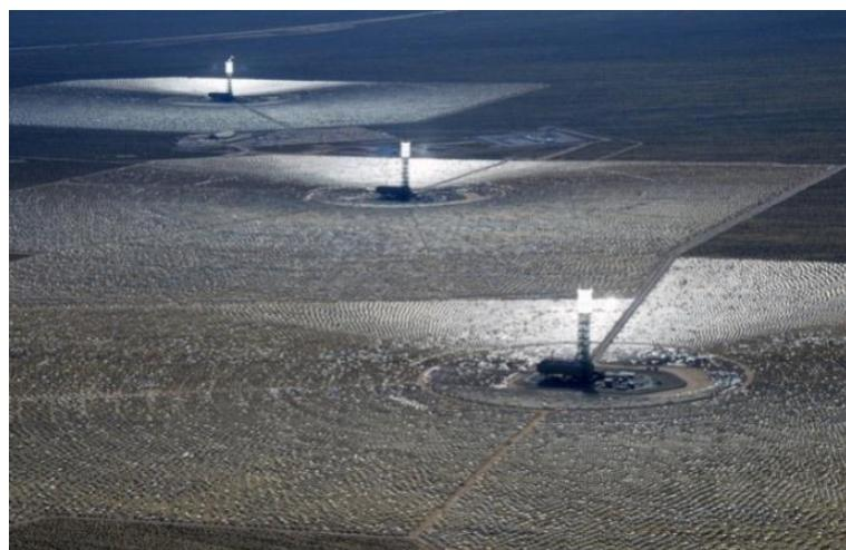
Sl.3.14. solarna termoelektrana Ivanpah s tri tornja s prihvativnikom i poljima heliostata [20]
