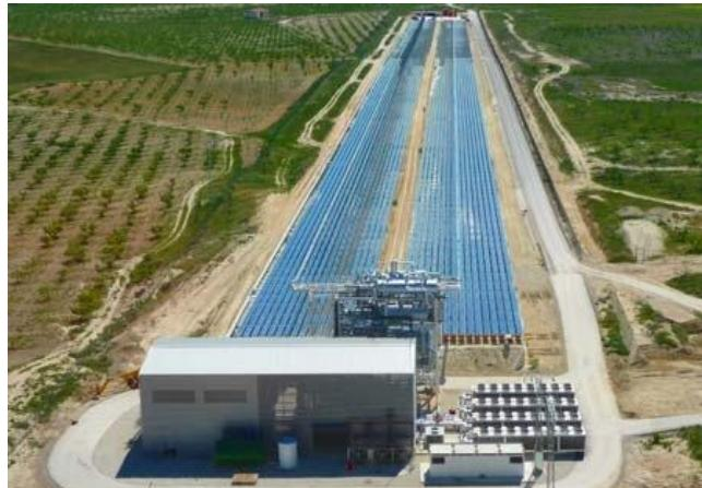
Sl.3.19. Solarna termoelektrana s Fresnelovim linearnim lećama Puerto Errado [27]
